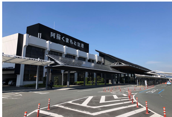
■ 太陽光発電システム
