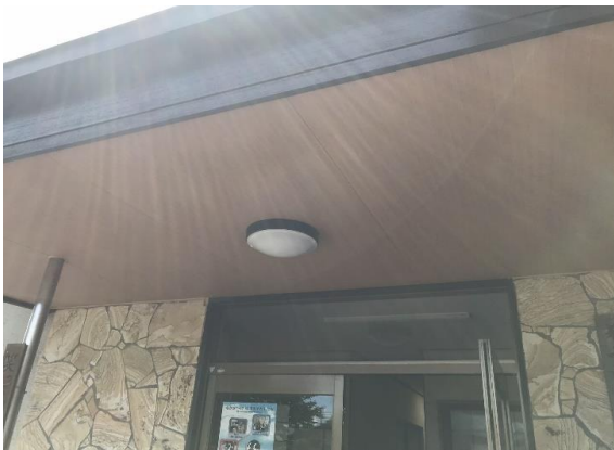
(玄関ポーチ工事)
