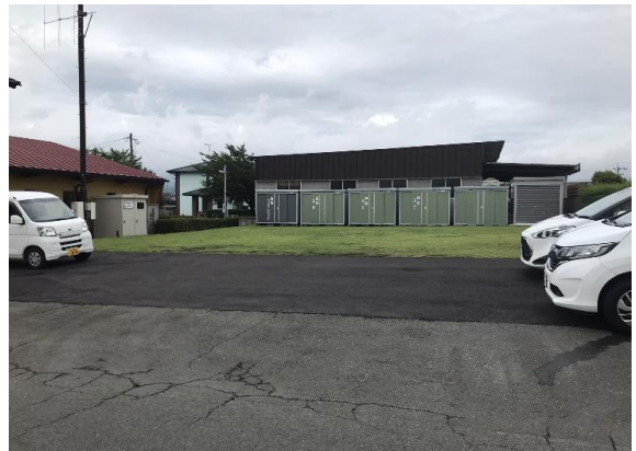
○西原村【①高遊コミュニティセンター】 (駐車場整備工事)
