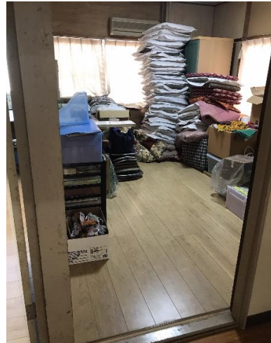
(和室→洋室への変更工事)
