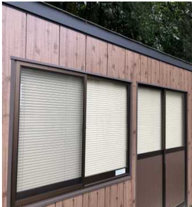
○熊本市【④託麻東部会館】 (ブラインド取付工事)
