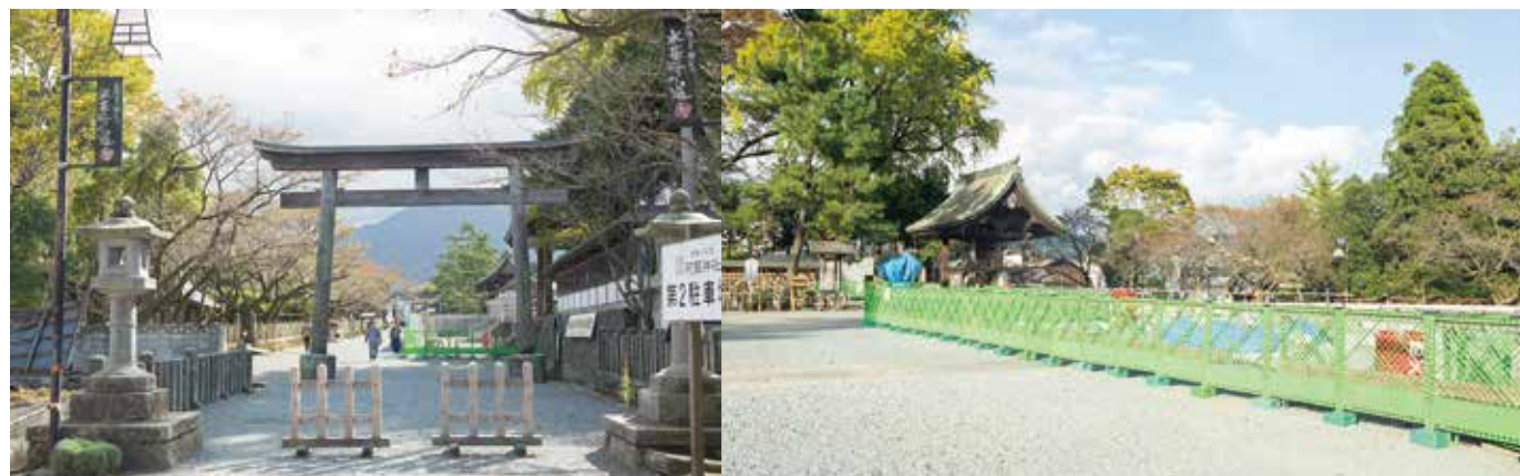
現在、楼門は解体され、復元工事が進められています
