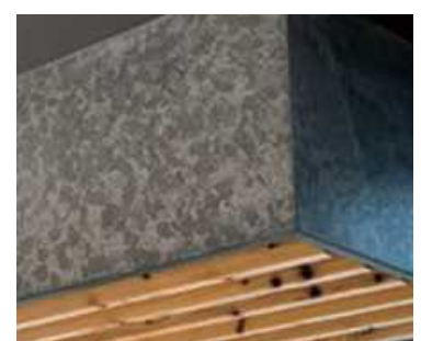
<石垣をイメージした仕上げ>
