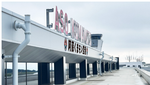
旅客ターミナルビル外壁：滑走路側
