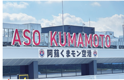
旅客ターミナルビル外壁：滑走路側
