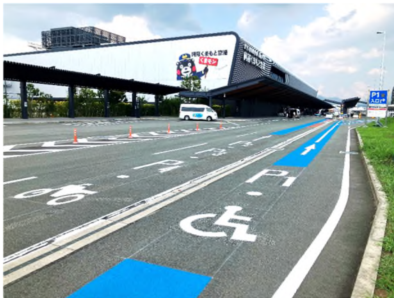
▲カラー舗装を施した空港構内道路
